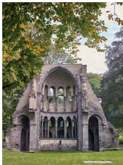
Chorruine des ehemaligen Zisterzienserklosters Heisterbach im Siebengebirge
