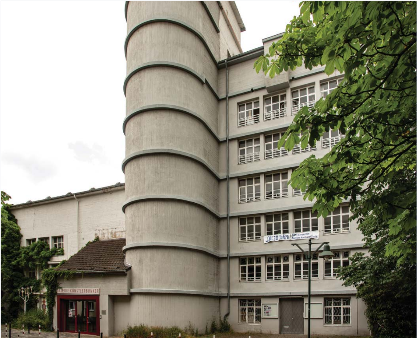
Bunker Karlstraße - Opladen
